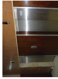
ELEVADOR 5 e 6 (4º ANDAR) Imagem 03
